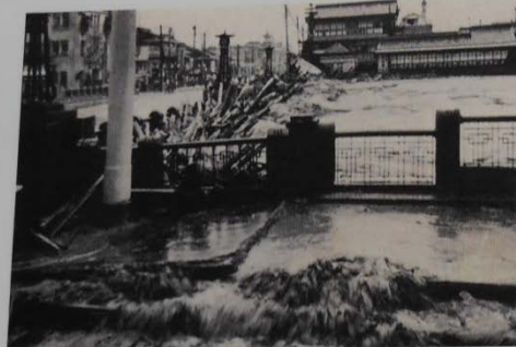
四条大橋付近のはん濫状況 出典:昭和10年6月29日水害写真(京都府)
